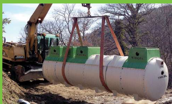
Installation d'une Tricel Novo FR20
