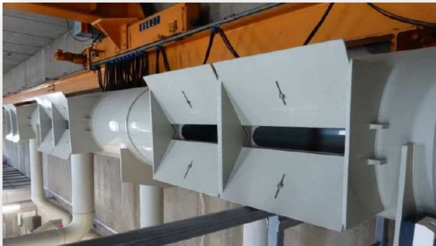
Exemple de réalisation de bouche d'extraction à fente réglable
