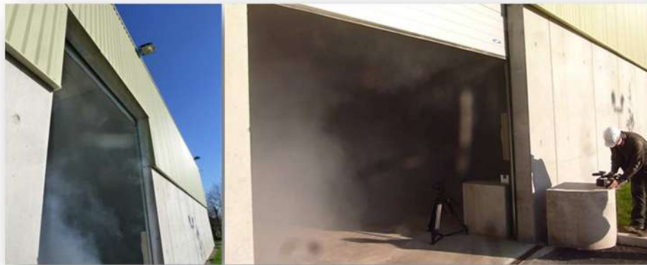
Test aux fumigènes : porte sectionnelle ouverte sur un site de compostage d'OMR
