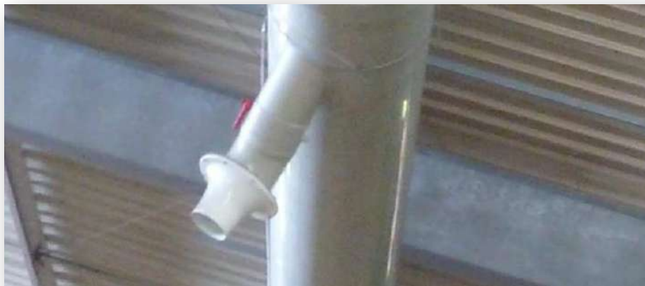
Détail d'une buse d'air neuf sur un piquage en gueule de loup
