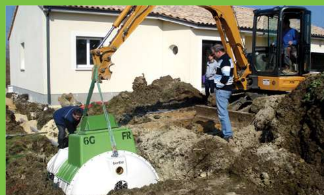
Installation d'une Tricel Novo FR6
